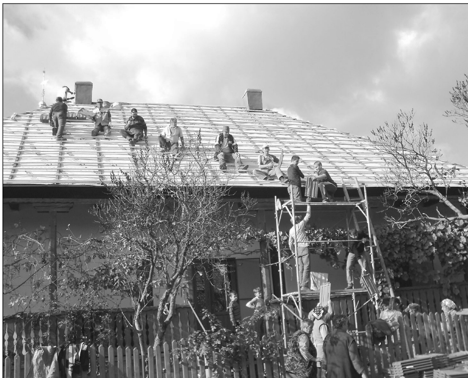
Közmunka a lelkészi lakás tetőfelújításánál
